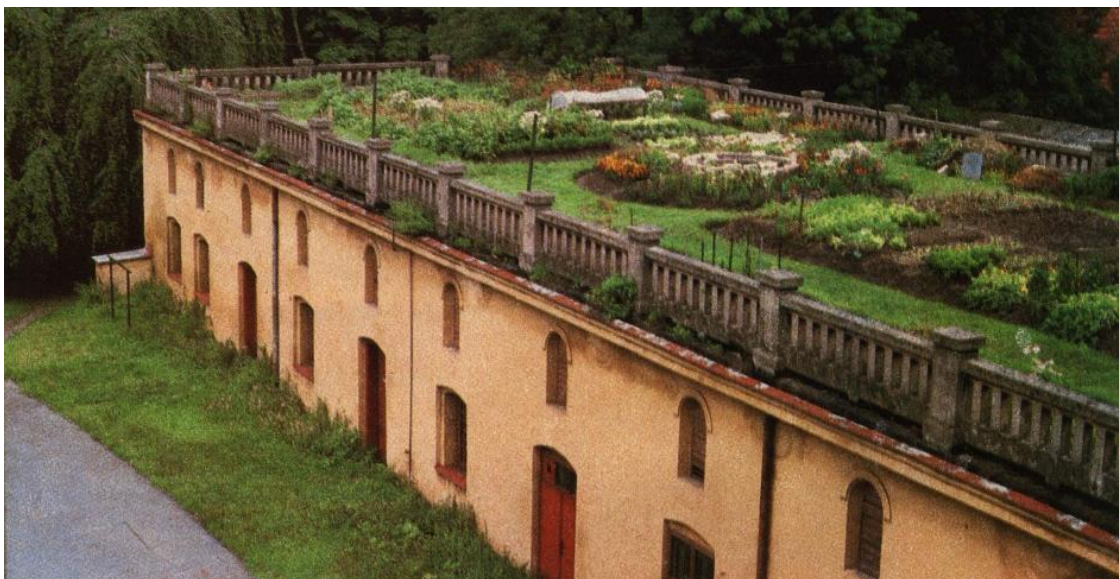
Obr. 3: Střecha konírny zámku v Lipníku nad Bečvou
