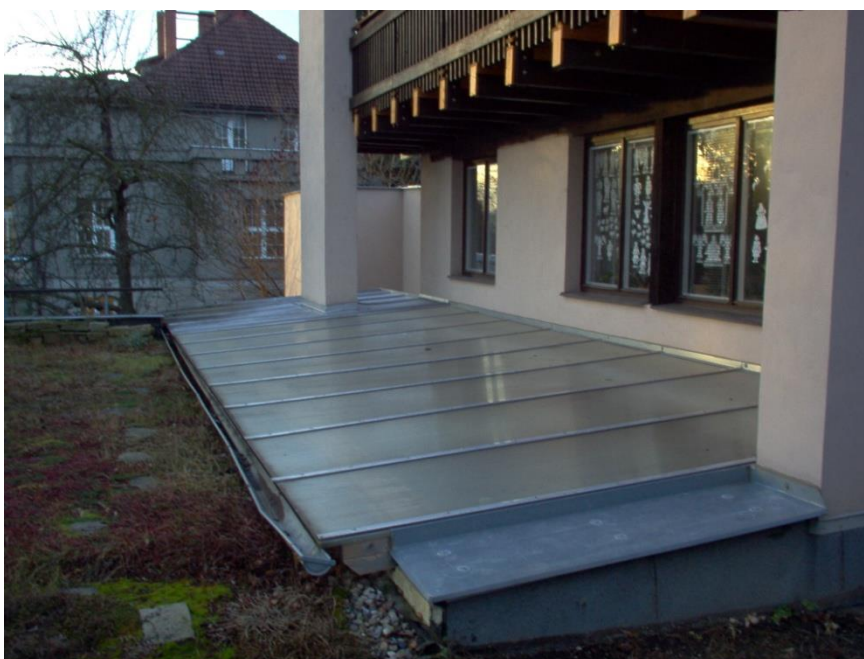
Obr. 10: Pohled na průhledné zastřešení
