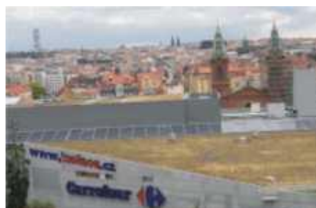
Obr. 6: Pohled na část ozeleněných střešních ploch
